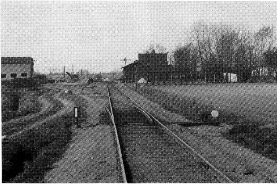
Seden station med sidespor til det nedlagte cikorieterri i billedets venstre side. Det var et 144 m langt blindspor, som visse tog mod Kerteminde bakkede ind på ved krydsninger. Billedet er taget mod VSV af Holtrup i april 1964.
