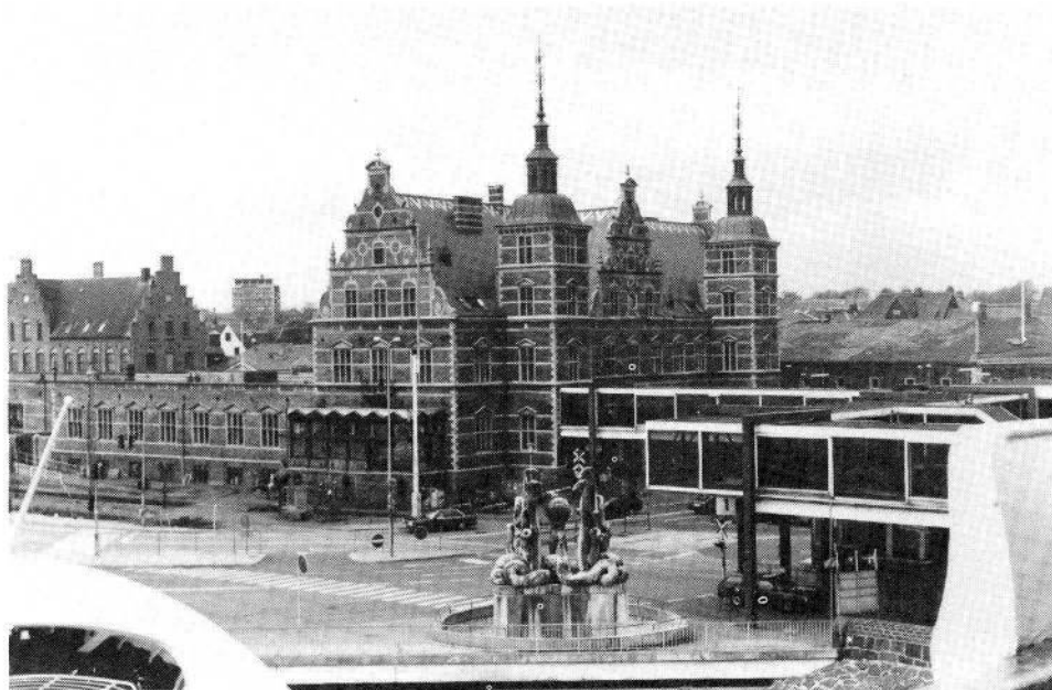
Helsingør station med gangbro til færgerne, 19/4 1989 (Foto: Ib V. Andersen)
