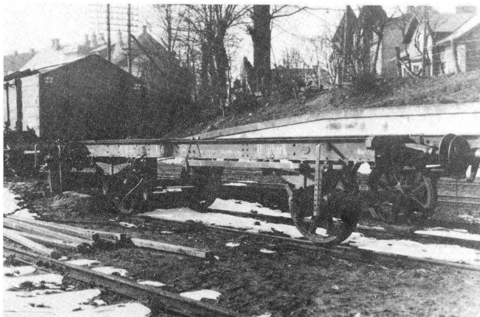
Fig. 69. Her mødes den smalsporede undervogn T 20 med den normalsporede U 6 og man ser det løse skinnestykke mellem de 2 vogne, hvorpå containerkassen F 22 (jf. næste foto) kan køre fra undervogn til undervogn. Billedet er fra tidligst 1926: T 20 ses at være revideret 2/10 1926! (arkiv SAG)
