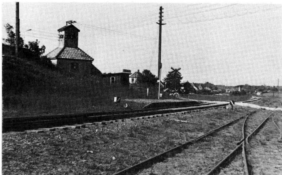
Transformertårn ved Ny Balle T, ETJ (E. Schou A.)
