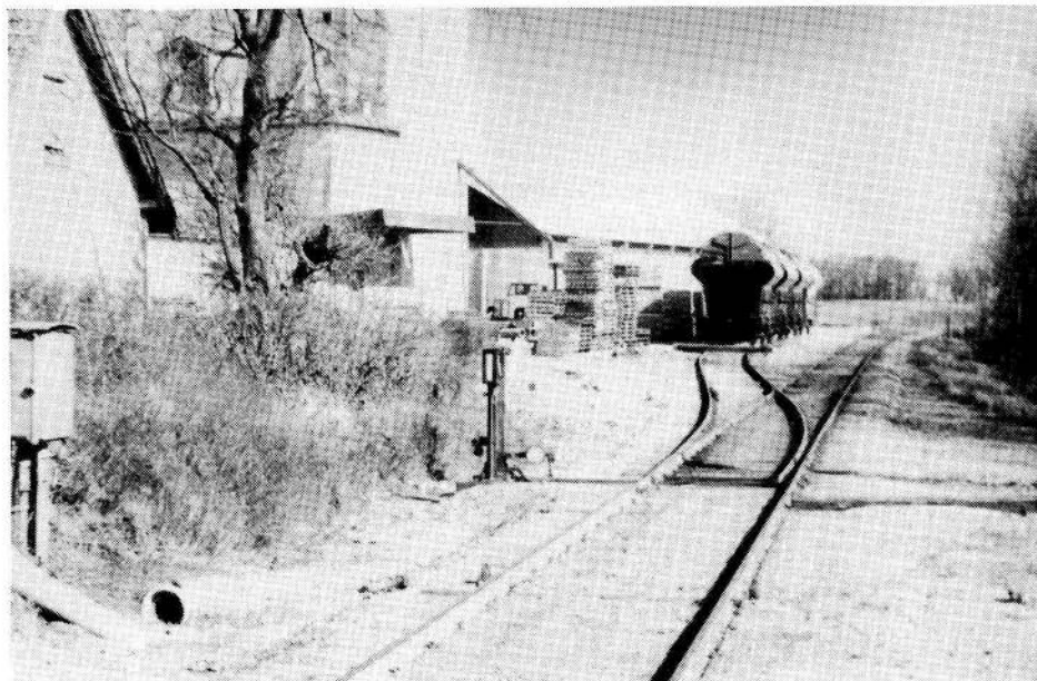
Fig. 6. Nordøst for Bonnet station på Lemvigbanen er der i årenes løb opført et stort siloanlæg med tilhørende korn- og foderstoflager. Et godt benyttet stikspor fører fra hovedsporet ind til virksomheden, kun sikret med svelle mod uønsket vognudløb i togvejen.
