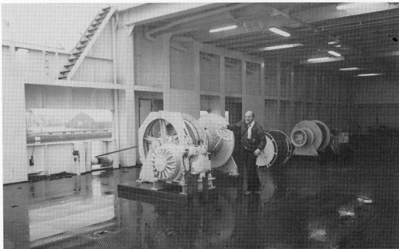
M/F TREKRONER: Fortøjningsspil på containerdækket. (24/10 1987)
