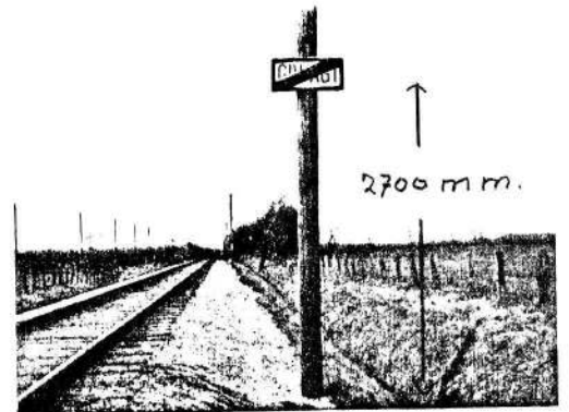
Rektangulær, hvid skive med rød kant og med påskrift »GIV AGT« samt rød skræstreg.
