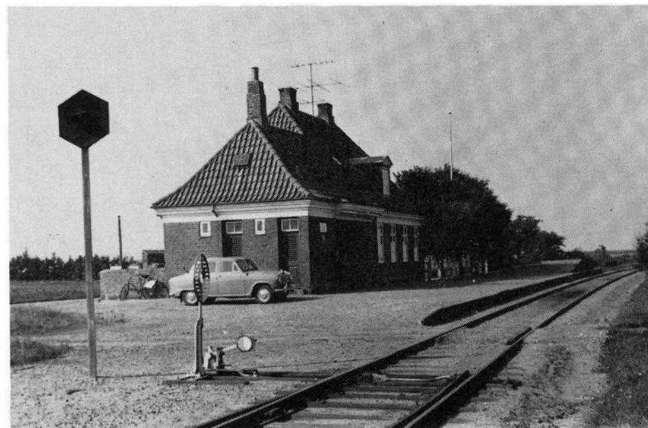
Øverst: VaGJ, Tyndkær. Indgangssporskifte fra Varde (aug. 1964, UH). Midten: Tyndkær, læskur og signal (aug. 1964, UH). Nederst: VaGJ, EG. Stationsbygning (aug. 1964, UH).
