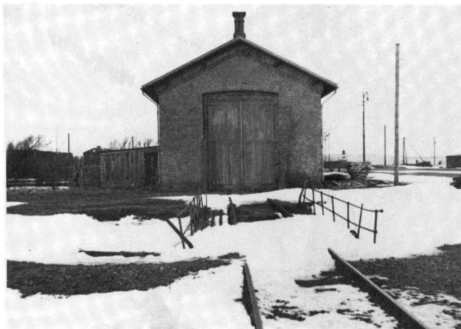
Fig. 100. Firkantet Remise med Drejeskive.
