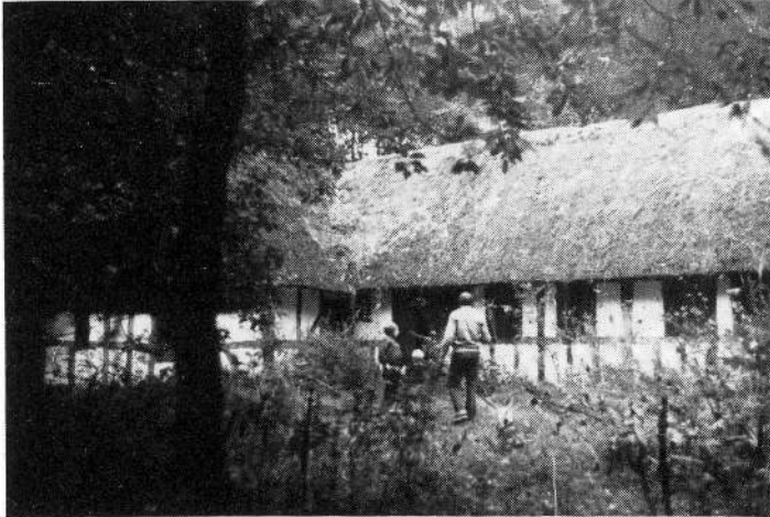
Den "rigtige" Blirup vandmølle, der er vort forbillede. Oprindeligt var møllen helt hvidkalket (som på Sjælland), men kalken er skallet af under møllens forfald, så bindingsværket træder kraftigt frem.
