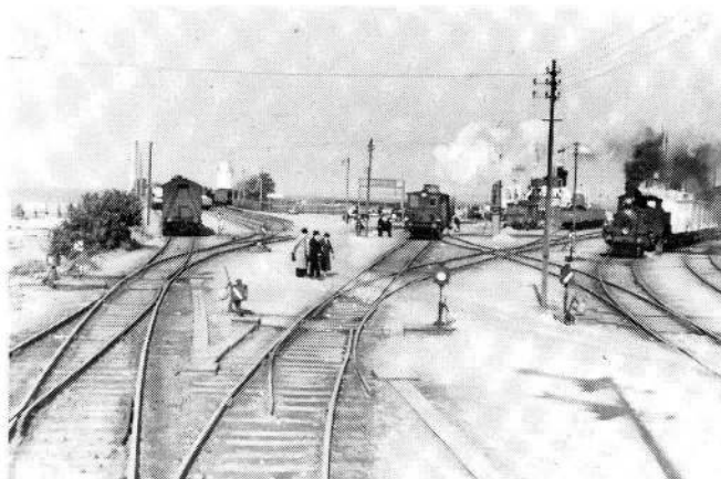
Fig. 27: Vi ruller videre og ser nu fra venstre mod højre: Gavlen af en CKK og noget længere tilbage en tankvogn. Rangermaskinen er i arbejde ved leje V med godsvogne til returferge II og tog 75 rangeres til spor I ad mellemsporet, hvilket ikke er i overensstemmelse med det på faseplanen viste (se forklaring i fig. 28). Forrest i tog 75 ses 4 ølvogne. Det er ikke helt klart, hvor de har været gemt under de foregående faser. Under alle omstændigheder havde de vacuumstyr. Bemærk skyggen fra armsignalet med de koblede arme, 1937 (T. Nellemann)
