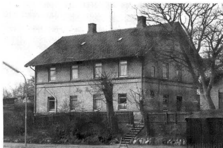
Fig. 11: Boligen set fra det tidligere sporareal, nu parkeringsplads. Den eneste ændring er de nye vinduer, men de gamle vinduer findes endnu på sydgavlen. 10. april 1982.
