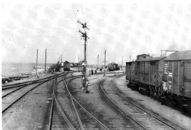
Fig. 28: Togvejsspor Ø - I (det direkte forbindelsesspor mellem spor Ø og spor I) viser sig at være belemret med afventende godsvogne. Den midterste er en tysk lukket godsvogn af litra Gb, bygget til Englandstrafik og derfor med smallere vognkasse og engelsk håndbremse, 1937 (T. Nellemann)
