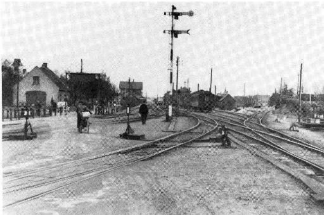
Fig. 13: Midterste del af stationen set fra nord. Huset yderst til venstre (med port) er isbådehuset. Gennemkørselssignalet havde koblede arme og anvendtes som udkørselssignal for de internationale tog (se teksten). To bogiepersonvogne med en hjælpevogn(?) imellem ses i depotsporet. Fjernest i sporet yderst til højre ses stationens snepløj, 1933 (T. Nellemann)
