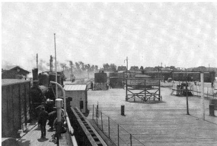
Fig. 24: Nogenlunde som fase 73.3-4: Rangermaskinen (F 482) har sat godsvogne ombord på returfærge I, mens tog 73's maskine damper stærkt for at sætte
