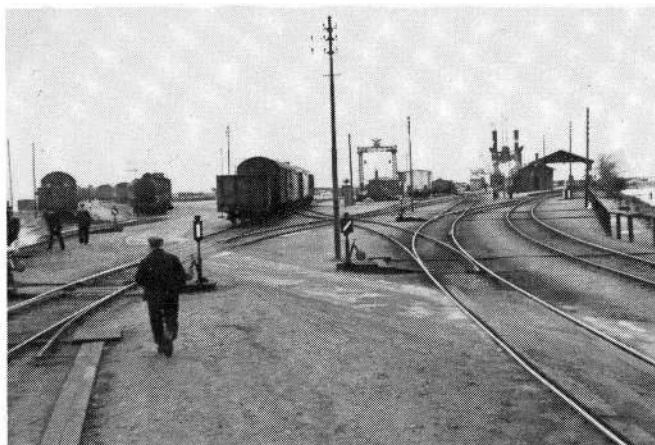
Fig. 14: Nordlige del af stationen med leje Ø til højre, leje V (med gitterportal) i midten, og opstillingsspor til venstre, 1936 (T. Nellemann)
