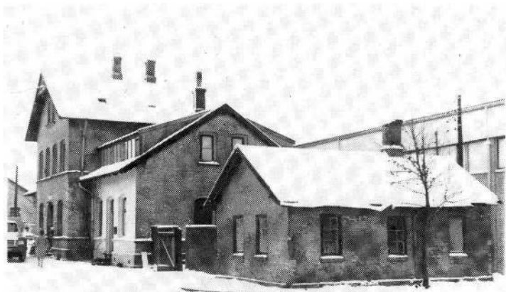
Fig. 9: Hovedbygningen og udhuset fra gadesiden, set fra nord. Bagved rejser sig finerfabrikkens haller. 29. december 1964.
