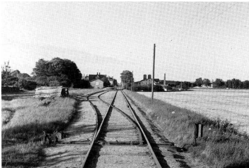
H0J, Ørting, indgangssporskifte fra Horsens, 8/65
