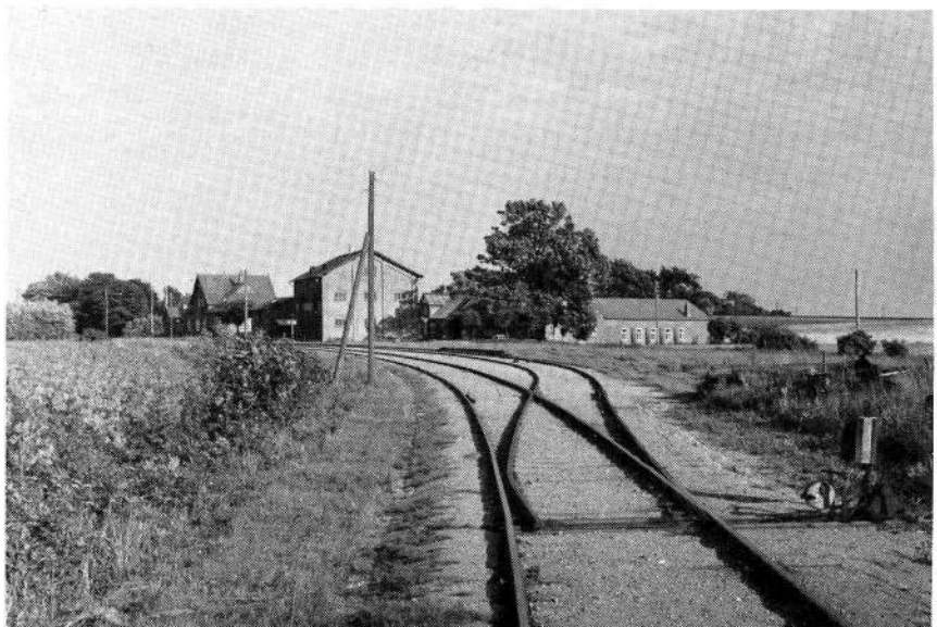
HOJ, Falling, indgangssoorskifte fra Horsens, 8/65
