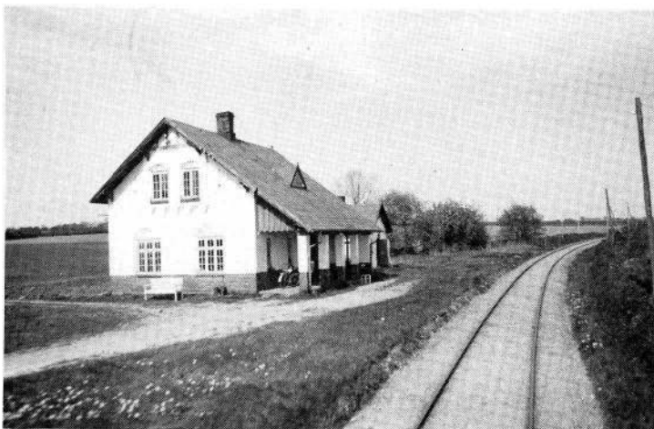
H0J, Torupvolde, gl. stationsbygning, set mod Odder, 8/65
