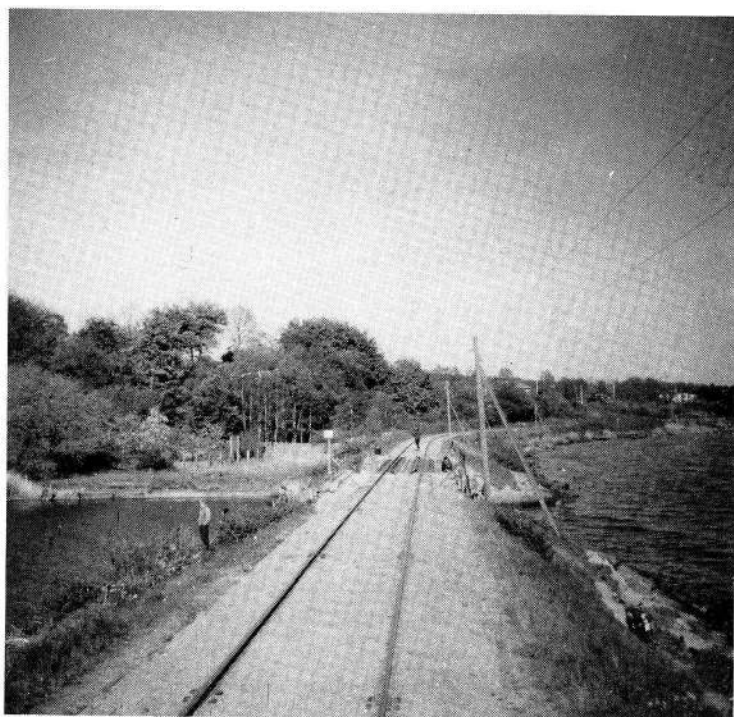
HØJ, på dæmningen ved broen ved Stensballe sund, 8/65
