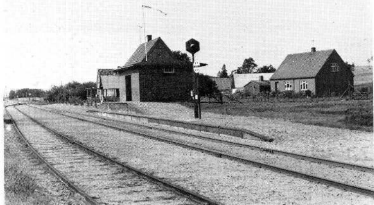
HBS, Fogstrup perron med vente- og lagerrum
