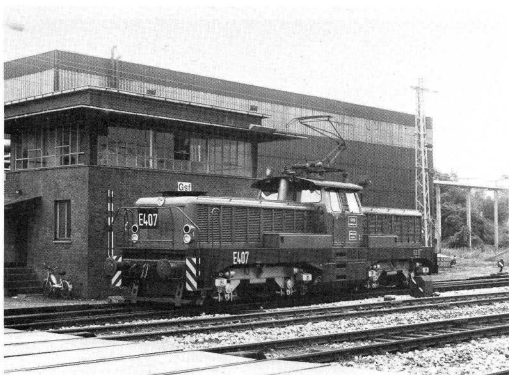
Fig. 3: RAG E 407, Henschel 31336 /1968. Et loko med ordinær udrustning. Vægten er som for E 005 - 88 t, men ydelsen kun 720 kW. Lokoet ses her foran signalposten på hovedværkstedet i Gladbeck. Farven er mørkegrøn/lysegrøn. Man råder over tolv af typen, der betegnes Ribernia (formentlig efter det gamle før-Rag-mineselskab). Foto: BH 1981.
