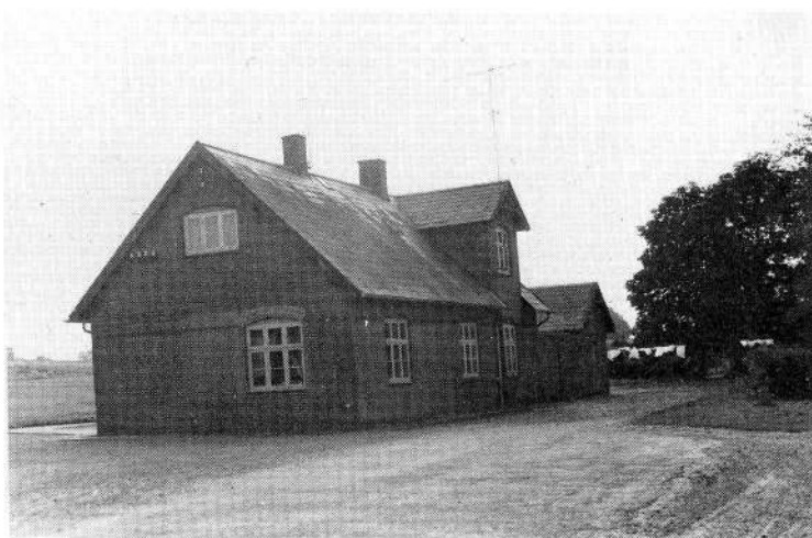
HBS, Tønning stationsbygning, vejside
