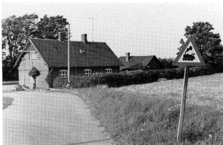
HBS, Vestbirk stationsbygning, vejside
