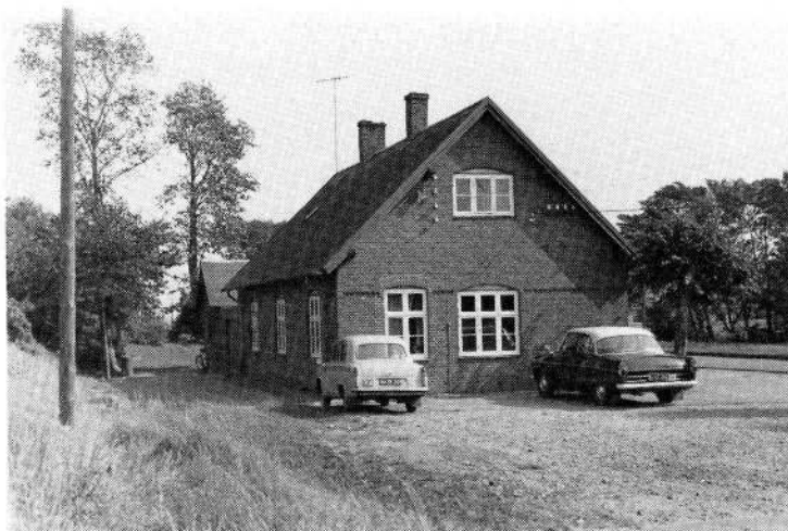
HBS, Vinding stationsbygning, vejside
