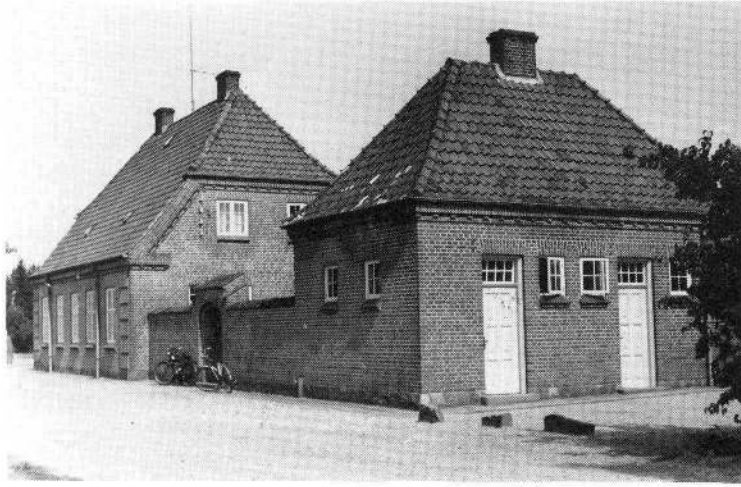
HBS, VRADS stationsbygning, vejside
