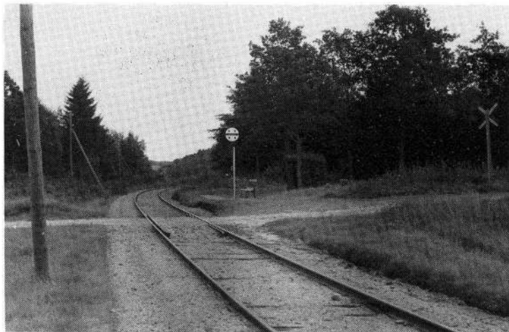
HBS, SKAANINGBRO indgangssporskifte Silkeborg
