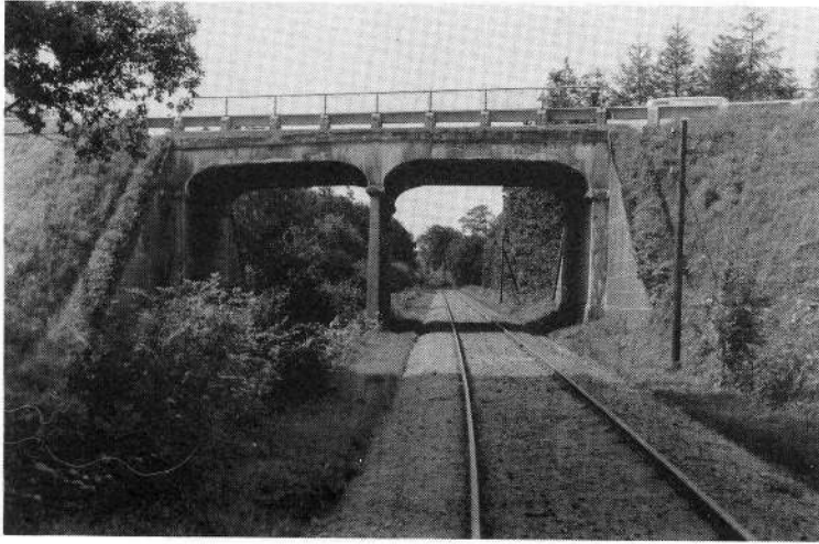
HBS, mellem Them By og Virklund viadukt for Horsens landevej
