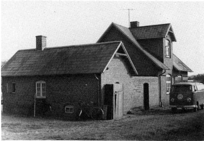
HBS, Gammelstrup, 1964 (hol) stationsbygning, vejside
