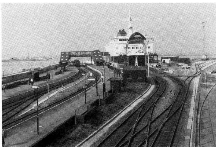
De nye anlæg i Korsør med M/F PRINS JOACHIM
