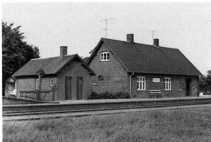
HBS, Tønning, 1964 (hol) toilet- og stationsbygning
