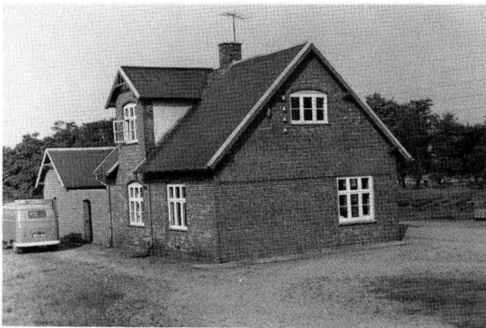
HBS, Gammelstrup, 1964 (hol) stationsbygning, vejside
