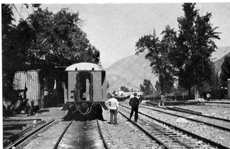
(Billed nr. 43): San Bartholome. Bemærk de forlængede bremseslanger som ender i et bremsehåndtag. Manden der står lige til højre for toget er "bagbremseren", som passer bremserne, når toget bakker i en zig-zag.
