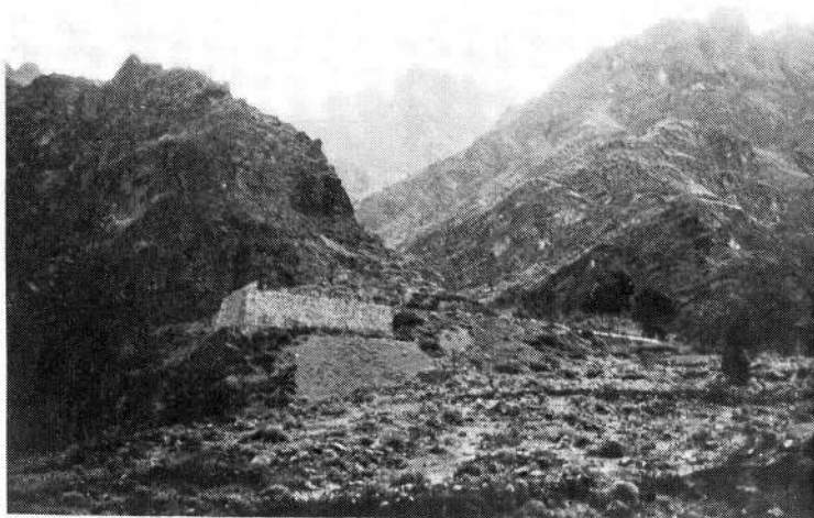
(Billed nr. 67): Chicla zig-zag, taget fra toget. Banen fortsætter et stykke til højre, drejer herefter 180° og går tilbage op til det nederste blindspor, som ligger på stenklodsen lige tv. for billedets midte.
