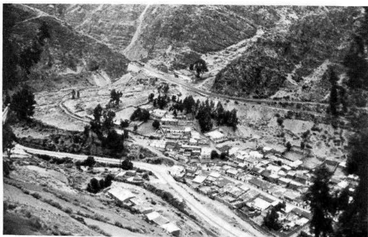
(Billed nr. 69): Chicla, set fra toget på vej op til det øverste blindspor. Banen kommer fra en tunnel gennem klippenåsen i billedets øverste venstre hjørne, drejer 90° og kan skimtes fornedet midt i billedet ved siden af landevejen. Derfra går den "skråt nedad" til højre, drejer 180° og går op til det nederste blindspor på stenklodsen, som ses lidt til højre for tunnelmundingen.
