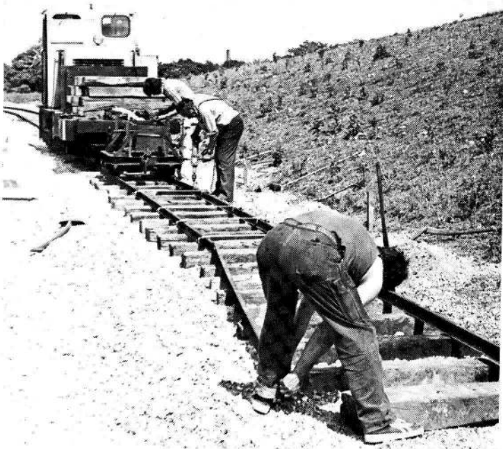
Sporlægning på HVB, juni 78.
