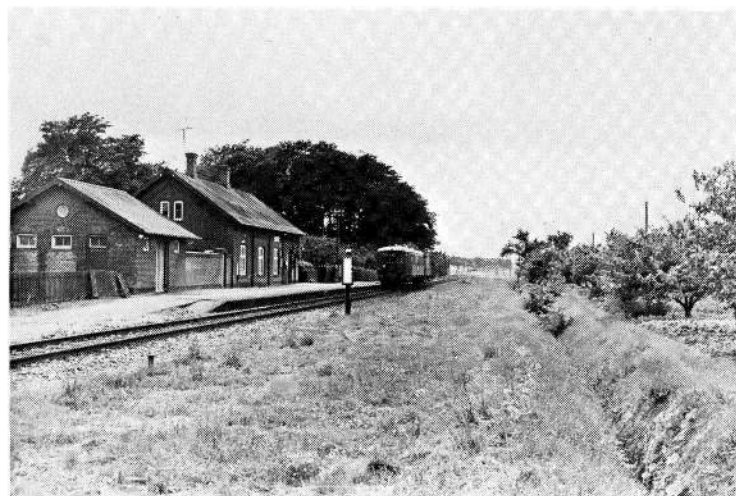
14: Alsø station med M 3 og E 1 (JJA)
