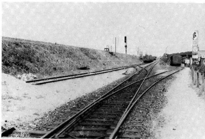
7. Masned Sund. Sporene nord for Volmergade. Sporet til venstre er det gamle hovedspor, i midten nuværende havnebane, til højre sidespor til FDB (bygget 1958). Billedet er taget sommer 1966 (JB-P)
