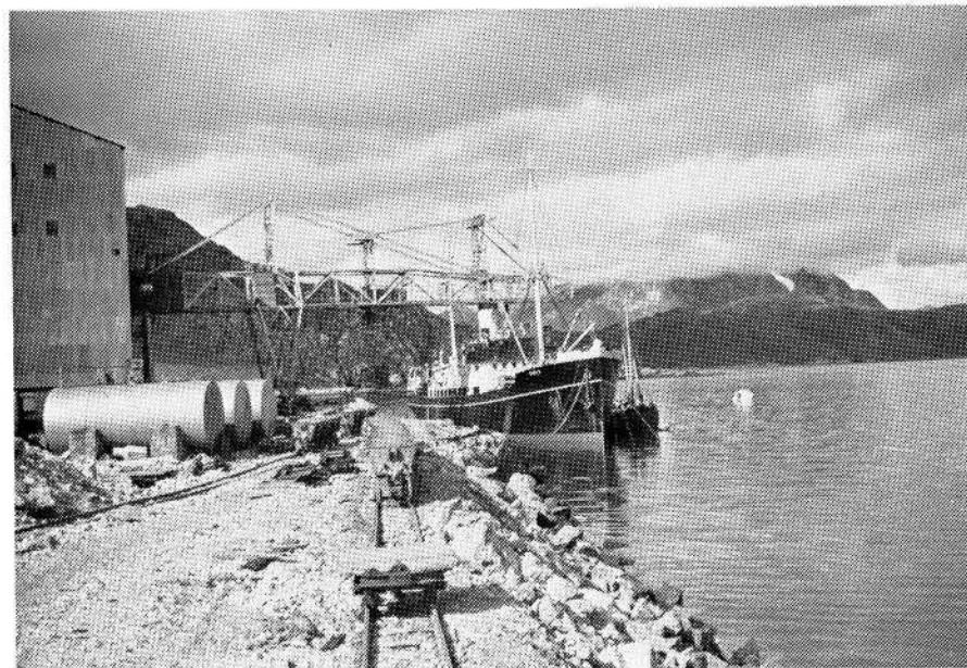
Fig. 6. M/S Disko under lastning. Skibet ligger et stykke fra "kajen". En vogn hænger i kranens lange udligger. På kajen to spor, et til læssede vogne og et til tømte (James Steffensen, 15. august 1947, neg. nr. 21.30).
