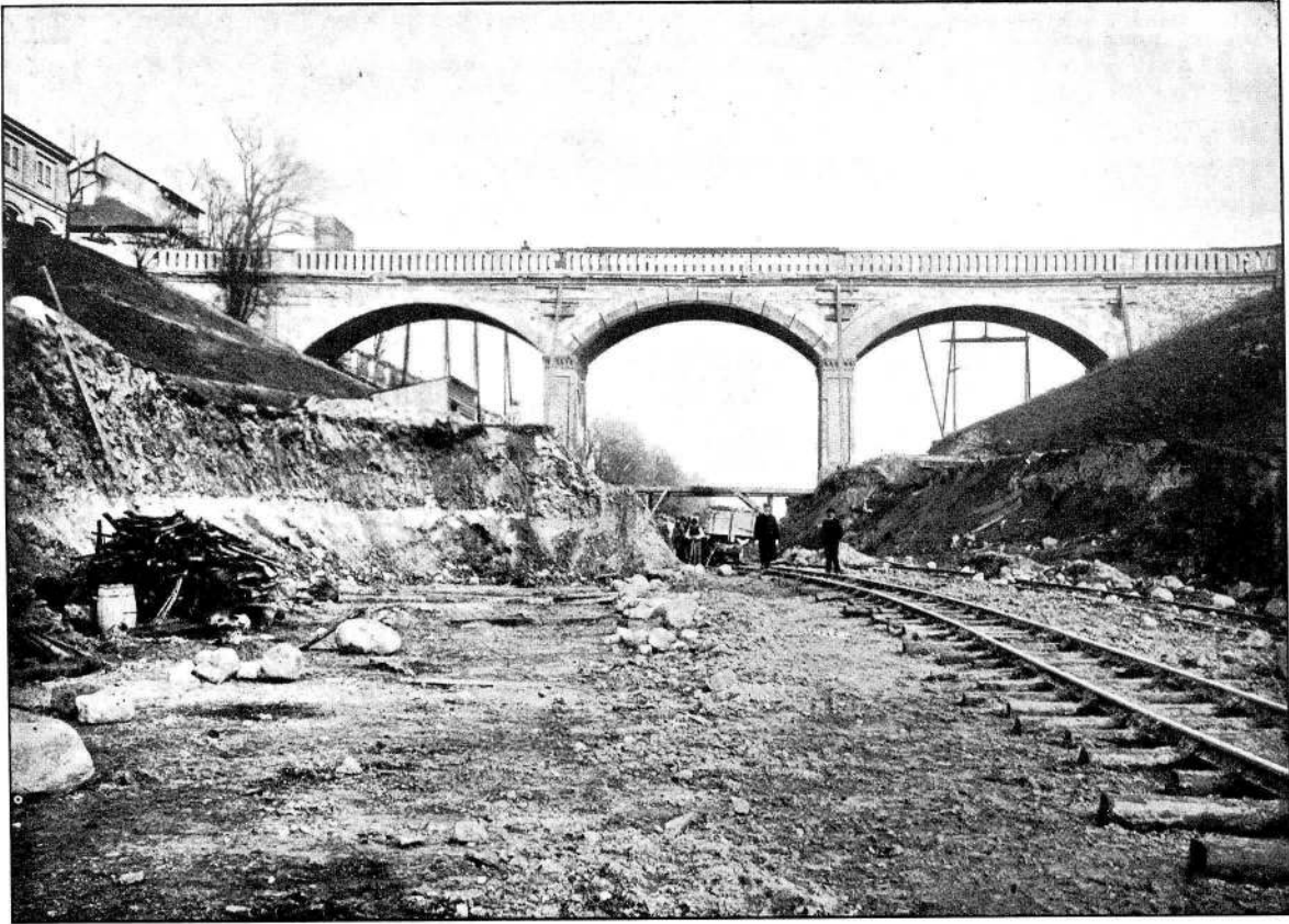
Den gamle Viadukt ved Carlsberg
